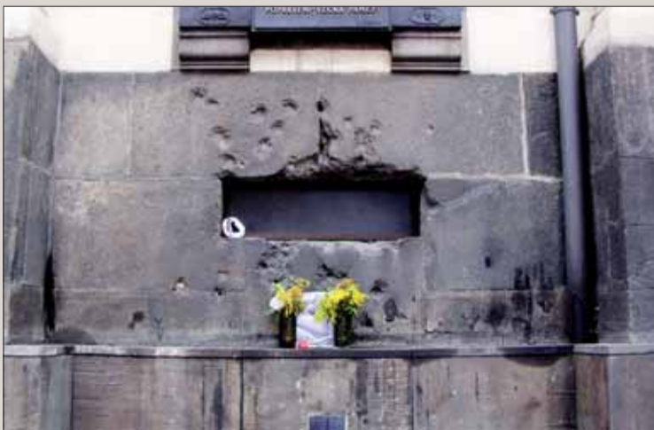
Okno do krypty Kostola sv. Cyrila a Metoda, ktorým púšťali dnu prúd vody a dusivý plyn.
