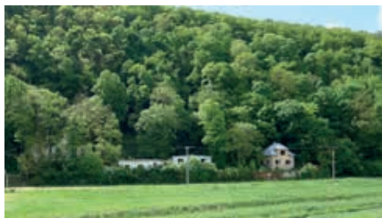
Pohľad na bývalý vojenský sklad na Veľkej Skalke Vstup do komôr vojenského skladu
