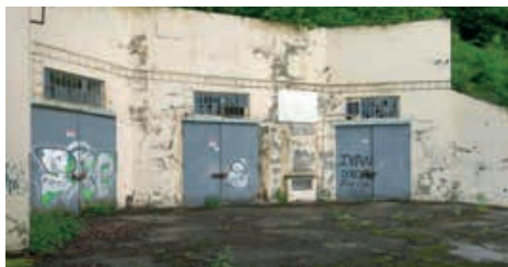
Pohľad na bývalý vojenský sklad na Veľkej Skalke Vstup do komôr vojenského skladu
